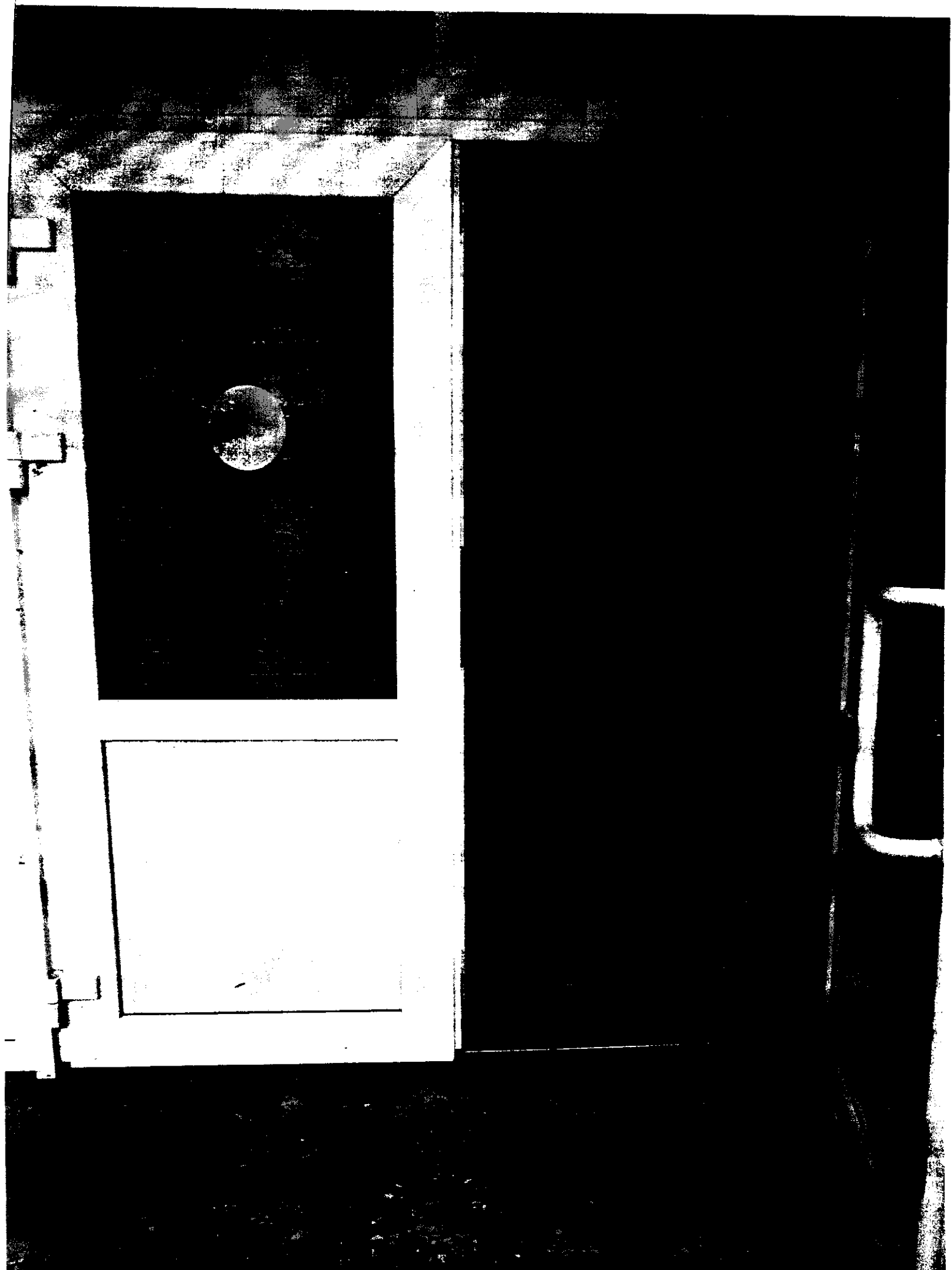
Вход в здание (дверь вогнутая) № 7
